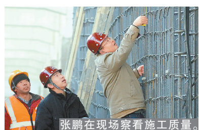
张鹏在现场察看施工质量。
