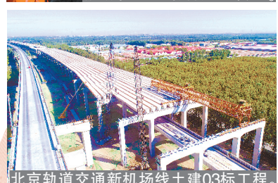
北京轨道交通新机场线土建03标工程。
