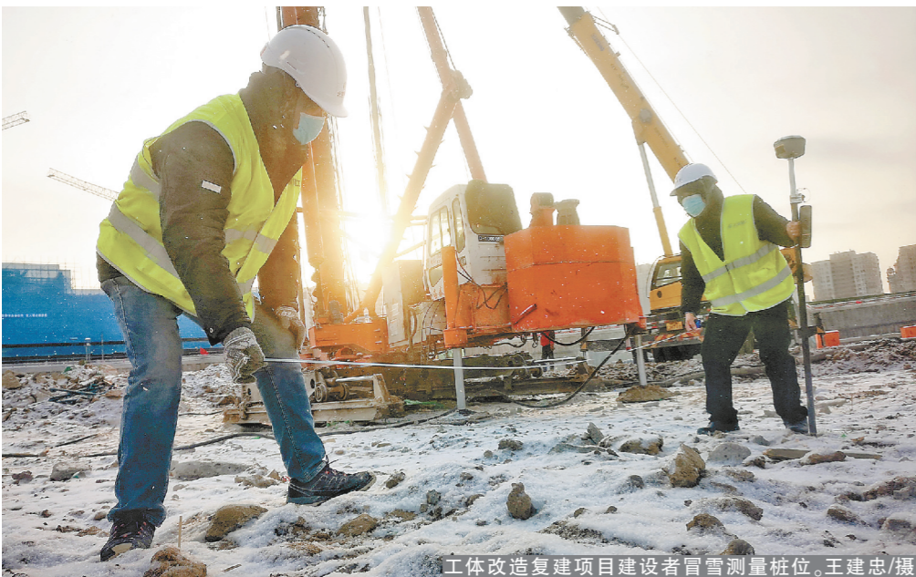
工体改造复建项目建设者冒雪测量桩位。王建忠/摄
