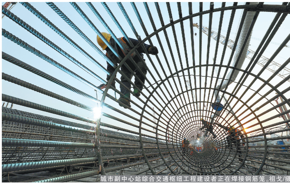
城市副中心站综合交通枢纽工程正在焊接钢筋笼。祖戈/摄
