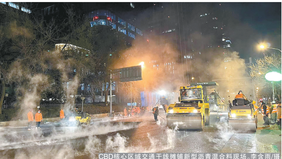
CBD核心区区域交通干线摊铺新型沥青混合料现场。李含雨/摄
