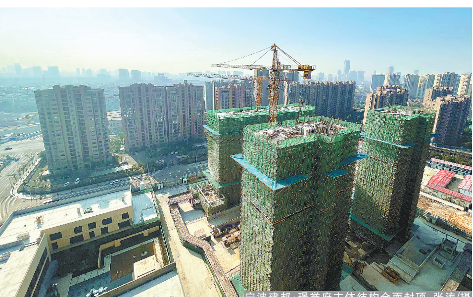
宁波建邦·璟誉府主体结构全面封顶。张涛/摄
