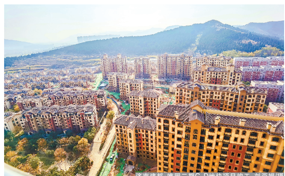
济南建邦·唯园二期C、D地块项目竣工。刘亚娟/摄
