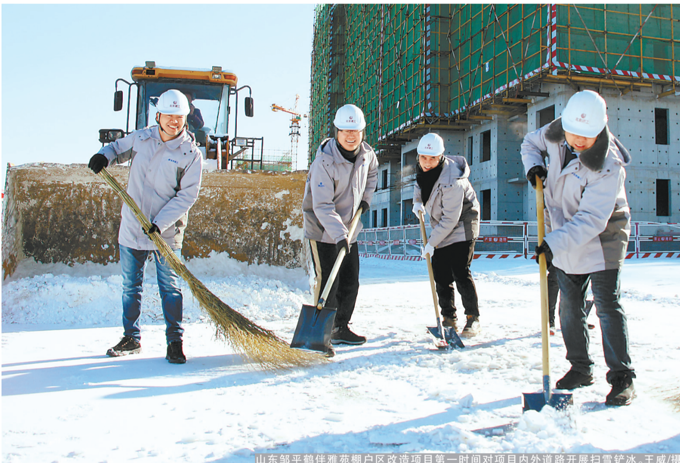
山东邹平鹤伴雅苑棚户区改造项目第一时间对项目内外道路开展扫雪铲冰。王威/摄
