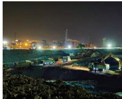
为确保工期节点，海淀区重点项目团队以“争一流、当冠军”为指导精神，动员全体项目管理人员及施工队负责人在保证安全、质量前提下，为改进施工工艺和方法献计献策。技术部门将现场分为8个区流水施工，对护坡桩、止水帷幕、锚索施工、土方施工等节点部位进行方案优化。现场进行不间断交叉作业施工以来，生产部门调整施工部署，质量、安全部门加大监督力度，及时反馈对改进后施工工序对质量、安全影响。
