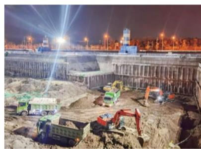
在现场管理方面，项目生产、安全、质量及班子人员扎根现场、连续作战，确保出现问题随时解决。在原施工7天一层的基础上，项目团队减少早强剂加快锚杆上度的时间，终达到5天一步锚杆，大大缩短了工期；同时与施工队伍签订协议书，每提前完成施工任务一天，对该队伍奖励3万元。项目团队通过不断的发现问题、分析问题、解决问题，现场施工进度逐步提高，赢得了业主的好评。经过近一个月的调整，6区率先达到了CFG桩的施工节点。目前，该工程有望在12月底完成土护降节点目标。
