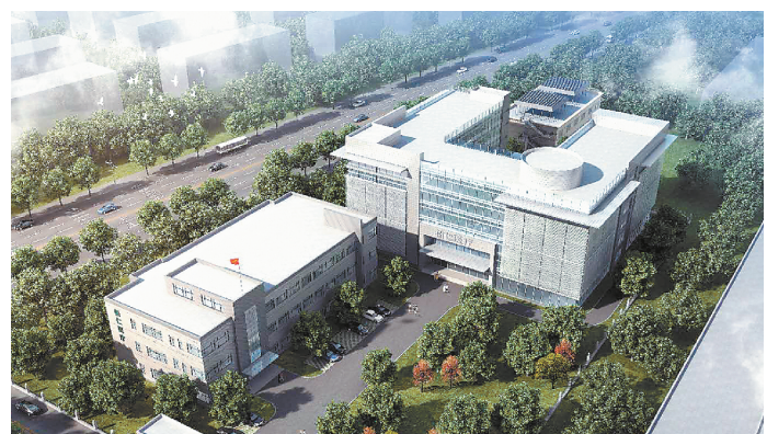
产业化公司昌平新城东区佰仁医疗二期工程。
