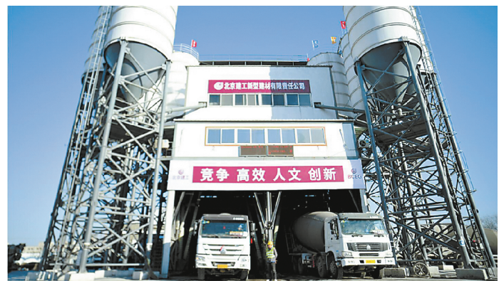
新材公司混凝土年产量稳定在550万立方米以上，单站产量突破百万立方米。
