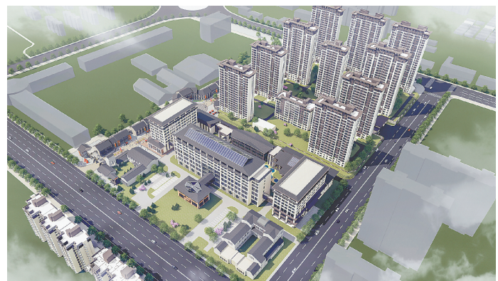
山西公司灵石县平型关广场及赛欧馨园工程。
