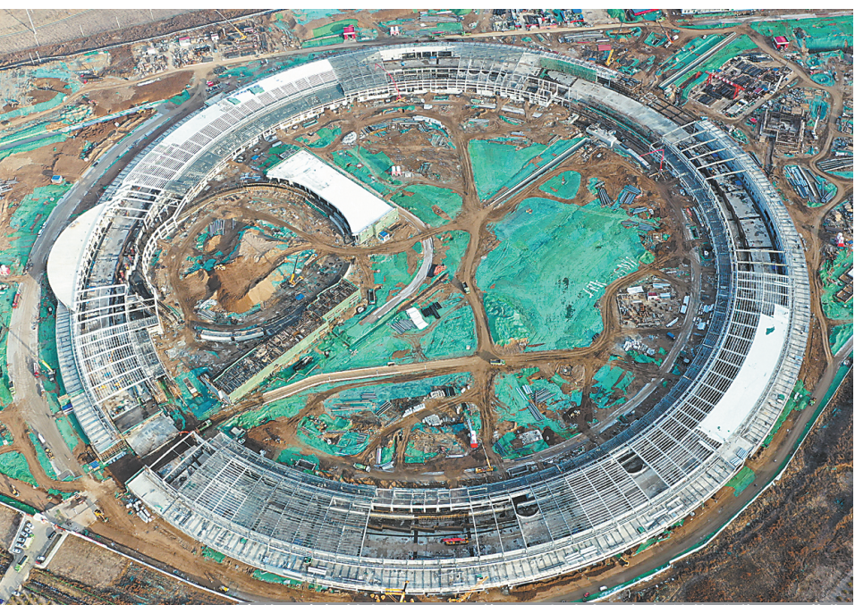
高能同步辐射光源项目1号装置区实验大厅超长结构隧道。邢国荣/摄
