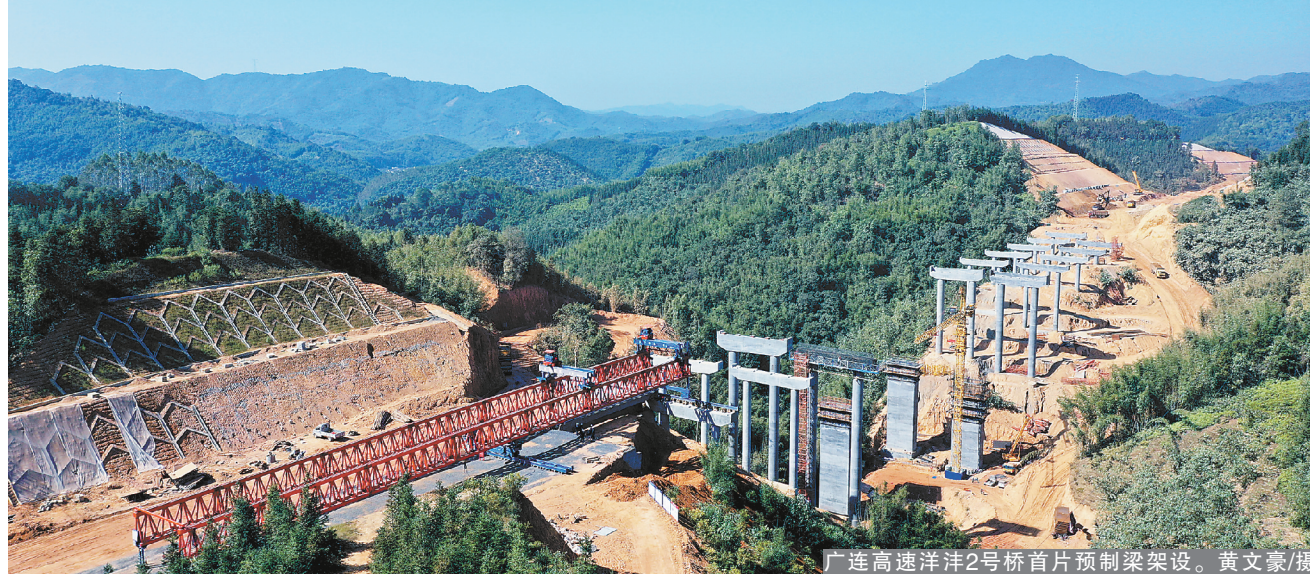
广连高速洋2号桥首片预制梁架设。黄文豪/摄
