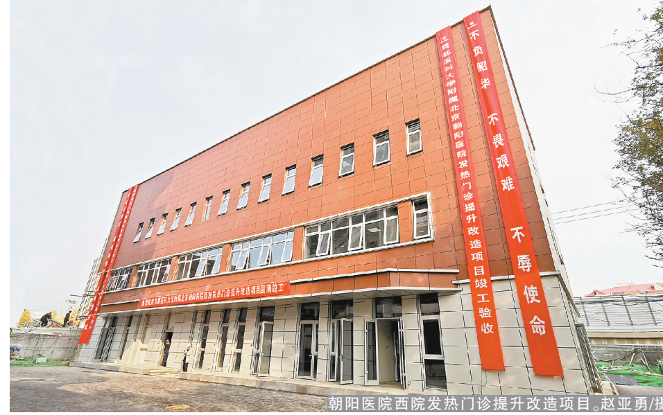
朝阳医院西院发热门诊提升改造项目 赵亚勇/摄
