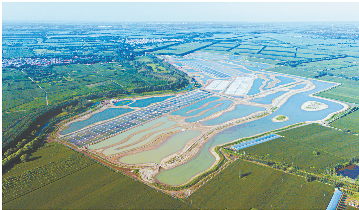
由集团建设者匠心打造的“入淀最后一道生态屏障”——雄安新区孝义河河口湿地水质净化工程。
