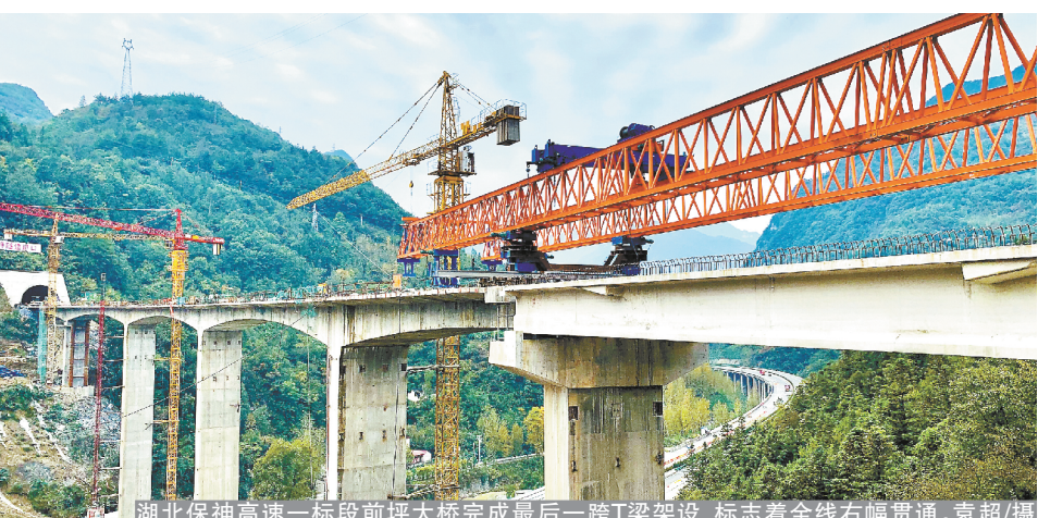
湖北保神高速一标段前坪大桥完成最后一跨T梁架设,标志着全线右幅贯通。袁超/摄
