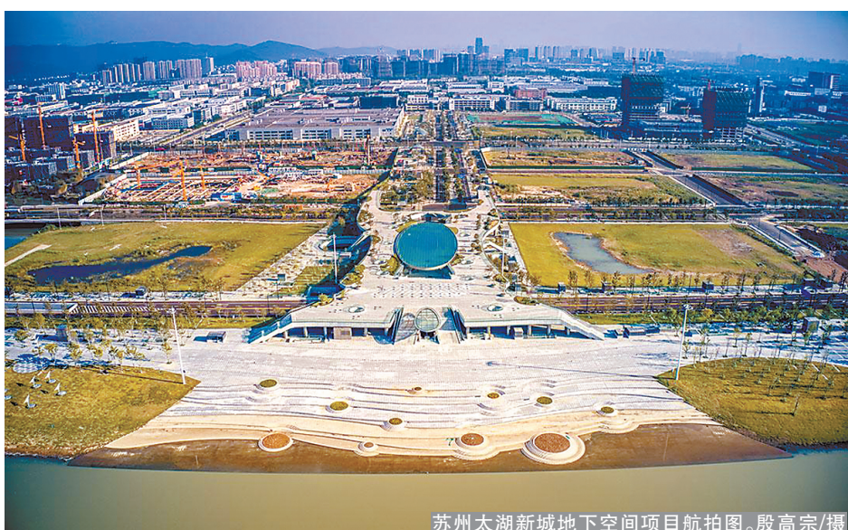
苏州太湖新城地下空间项目航拍图。殷高宗/摄
