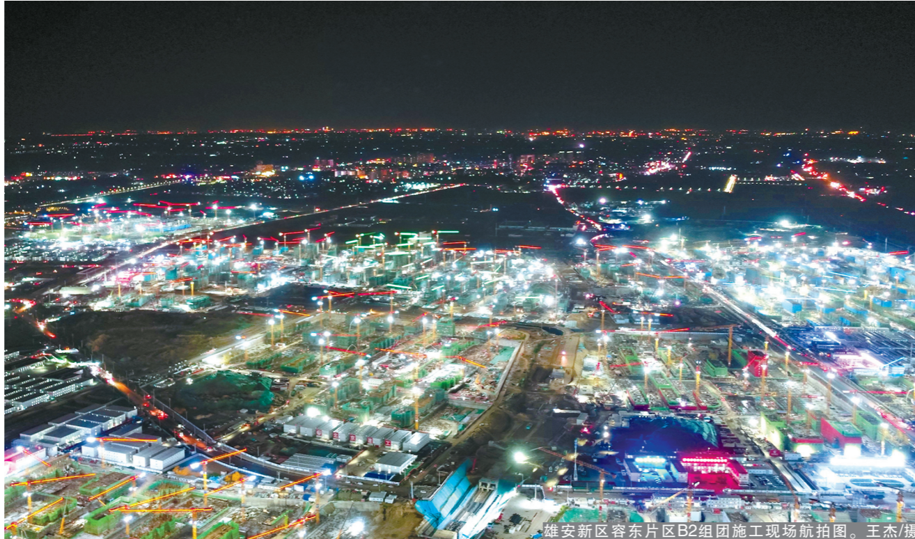
雄安新区容东片区B2组团施工现场航拍图。王杰/摄
