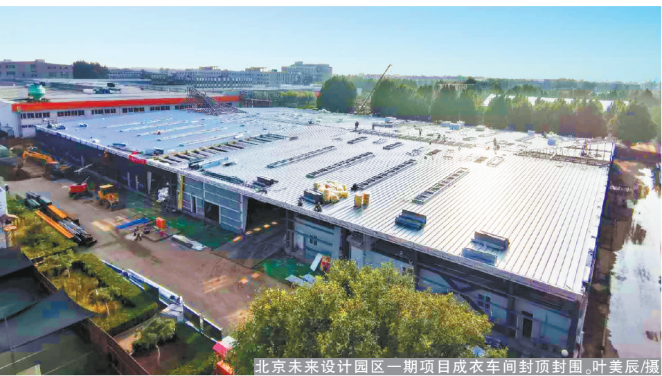
北京未来设计园区一期项目成衣车间封顶封围。叶美辰/摄
