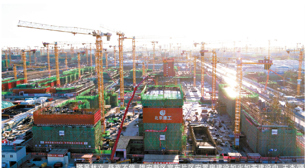
塔吊林立,昼夜不停,雄安新区容东片区安置房建设如火如荼建设中。王杰/摄
