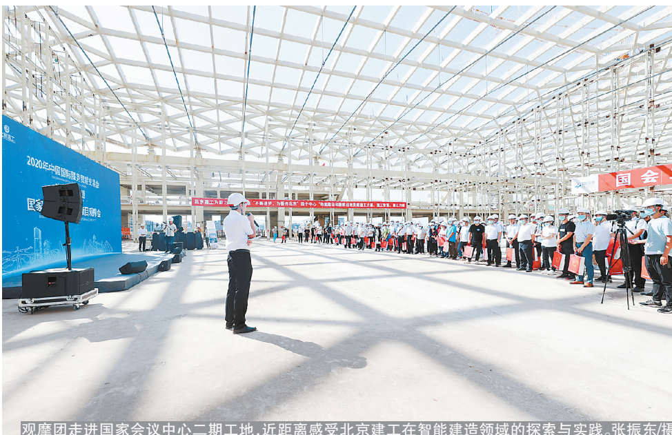
观摩团走进国家会议中心二期工地，近距离感受北京建工在智能建造领域的探索与实践。张振东/摄
