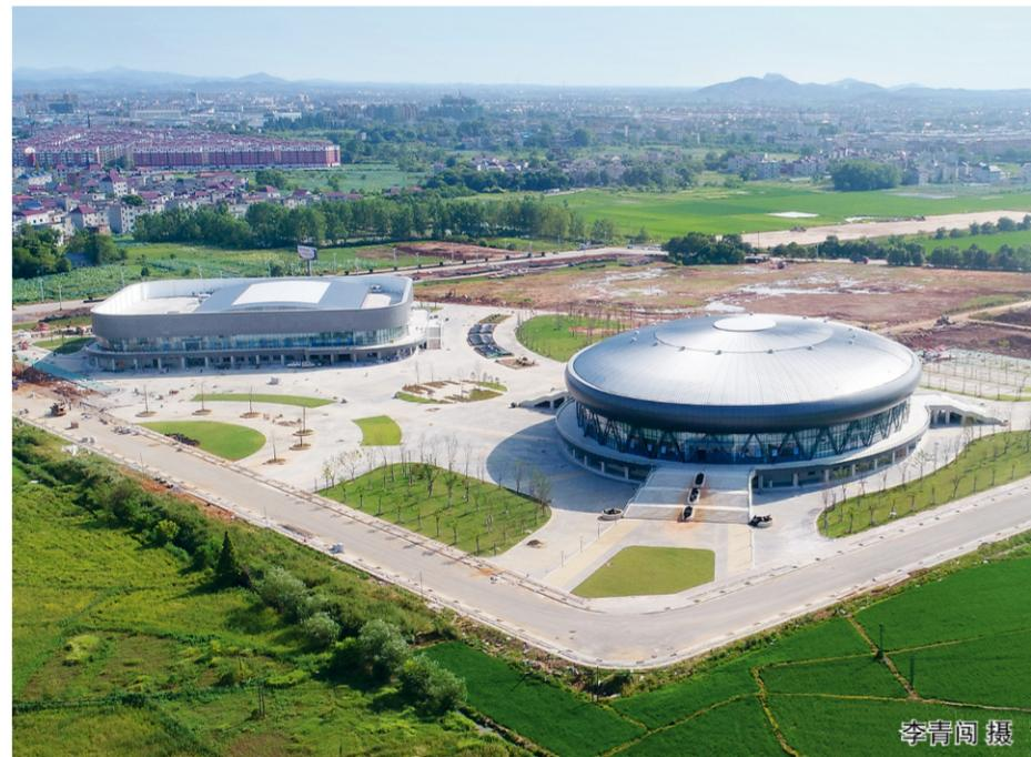
缘焊接后嵌杆部分，仅结构曲面网架部分（不含铝板屋面面层和附属装饰檩条）用钢量达425吨，如何在保证工期、质量、安全的前提下，有效解决曲面网架钢结构安装问题，成为体育馆施工面临的主要难题。
