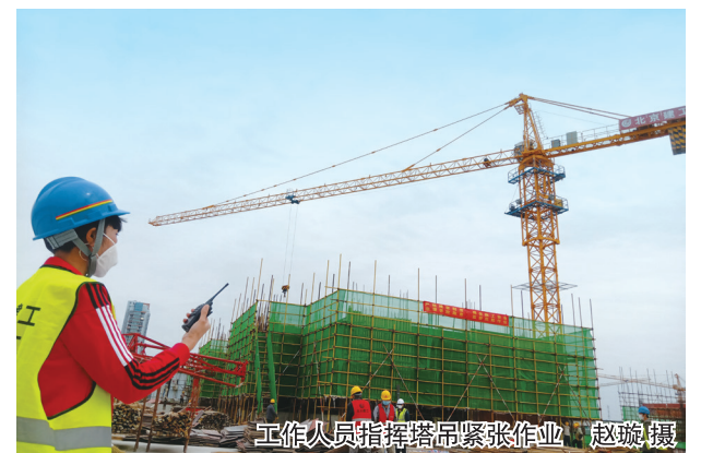
工作人员指挥塔吊紧张作业 赵璇摄
