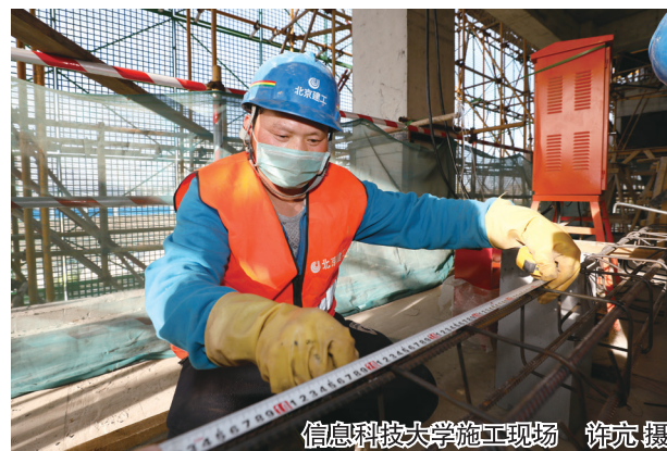
信息科技大学施工现场 许亮摄
