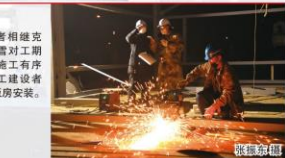
▼ 项目建设者与疫情竞速，同时向赛跑。图为现场建设者在钢板切割，准备项目配套设施。 王英明摄
