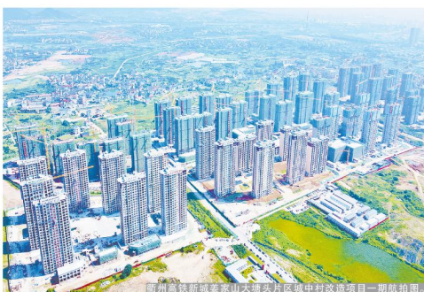
衢州高铁新城大塘头片区安置房一期项目全面封顶。
