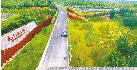
河北武安九龙山矿山生态修复工程三标段通过竣工验收。
