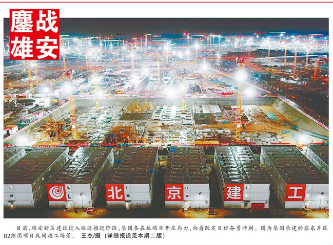
日前,雄安新区建设进入快速推进阶段,集团各在施项目开足马力,向着既定目标奋力冲刺。图为集团承建的容东片区B212组团项目夜间施工场景。王杰摄(详细报道见本期二期)
