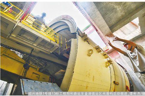
绍兴地铁1号线13标工程阳和路站至鉴湖站区间盾构启动掘进。董彬杰/摄
