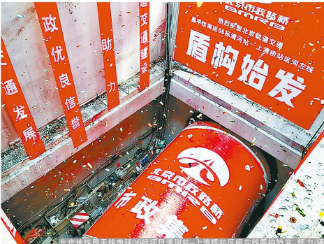
北京地铁昌平线南延06标项目清湖站—上清桥站区间左线盾构始发。盖力/摄
