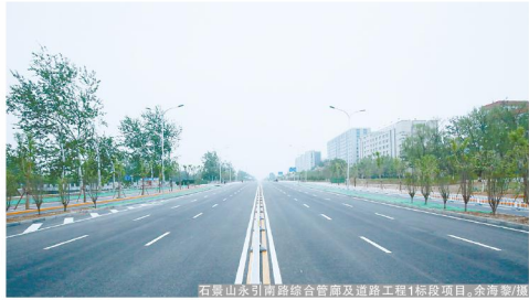
石景山永引南路综合管廊及道路工程1标段项目。余海琴/摄
