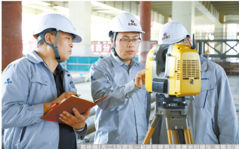
苏中帅(左二)与团队成员一起对某项目工程进行测量作业
