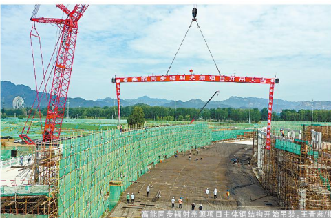
高能同步辐射光源项目主体钢结构开始吊装(王晋文摄)
