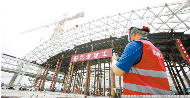
国家会议中心二期项目钢屋盖开始滑移铺装(程戈摄)
