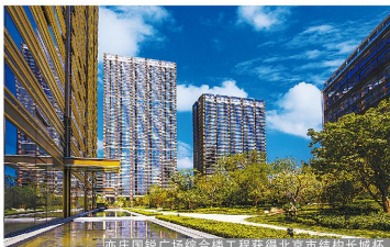
亦庄国际广场综合楼工程获得北京市结构长城杯
