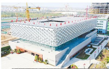
用时93天，建成国内首创产融展馆建筑——大同采煤沉陷馆
