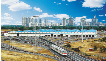
承接的第一项轨道交通工程——北京地铁四号线南段工程
