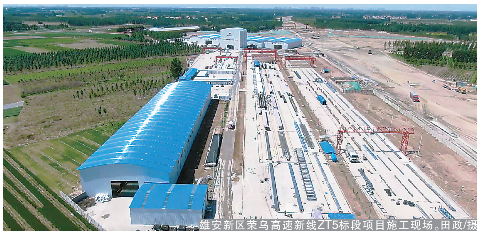
雄安新区荣乌高速新线ZT5标段项目施工现场。田政/摄
