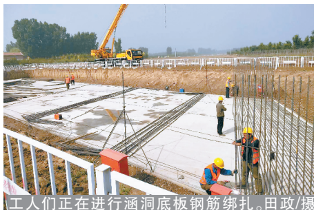
工人们正在进行涵洞底板钢筋绑扎。田政/摄
