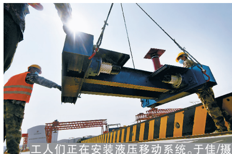
工人们正在安装液压移动系统。于佳/摄
