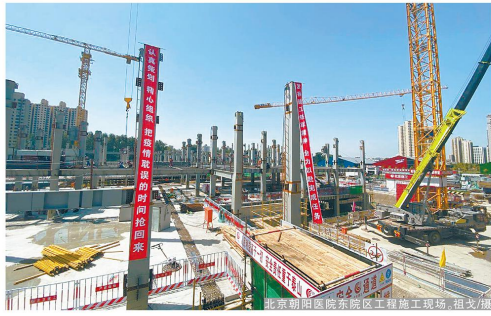
北京朝阳医院东院区工程钢结构施工现场,赵旭摄
