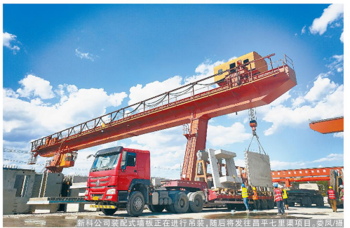
新材公司装配式墙板正在进行吊装,随后将发往昌平七里渠项目,梁凤雁
