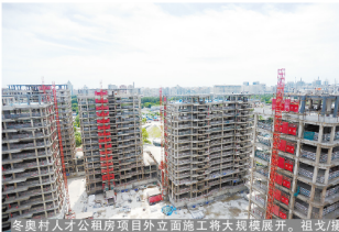
冬寒料峭，北京建工集团重点工程抢抓施工黄金期，开足马力保生产。
