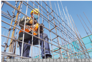
北京建工集团重点工程抢抓施工黄金期，开足马力保生产。
