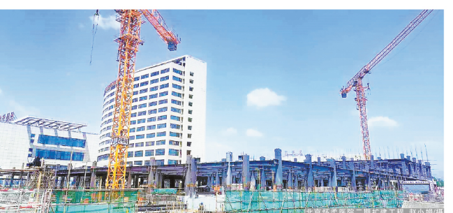
北京怀柔医院二期扩建工程 赵小娟摄
