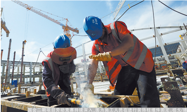
国会二期项目劳动竞赛持续深入，图为施工人员进行装饰柱预埋固定，祖戈/摄
