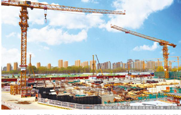
在房山长阳06.07棚户区改造项目施工现场，装载材料的运输车有序进出，塔吊忙碌地起升转动，560余名工人正在紧张地绑钢筋、支模板作业……现场一片火热的施工景象。
