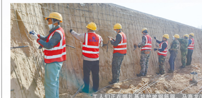
工人们正在绑扎基坑支护钢筋网。 马涛/摄
