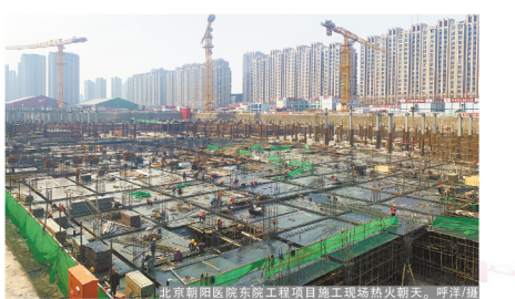
北京朝阳医院东院工程项目施工现场热火朝天。呼洋摄
