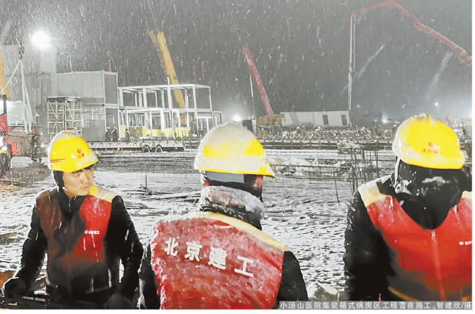
小汤山医院集装箱式病房区工程雪夜施工。智建政/摄
