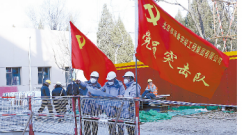
安装集团突击队安装电梯井钢结构。刘小平/摄
