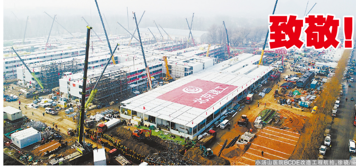
小汤山医院BCDE改造工程项目部,徐敏/摄
