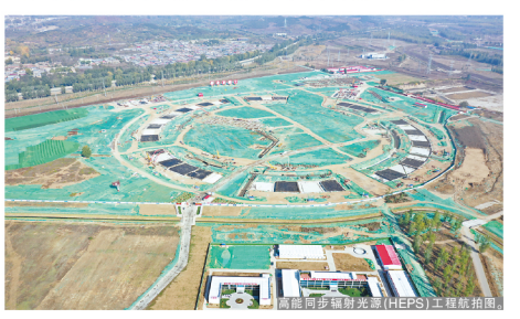
高能同步辐射光源(HEPS)工程航拍图
