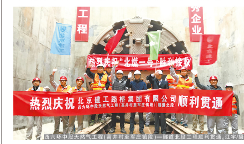
六环中成段天然气工程(高井村窑庄镇)一隧道北段工程顺利贯通,江宇摄
