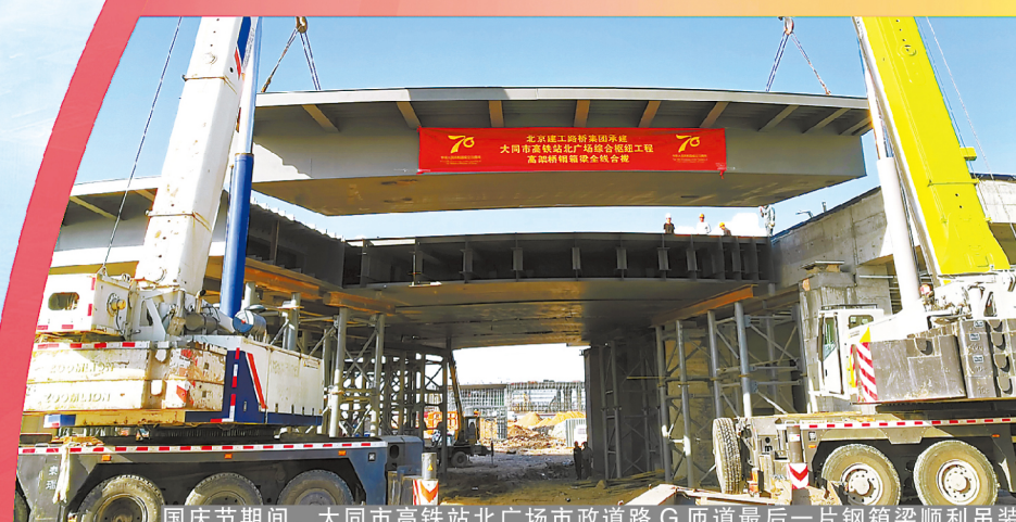
国庆节期间，大同市高铁站北广场市政道路G匝道最后一块钢箱梁顺利吊装。
