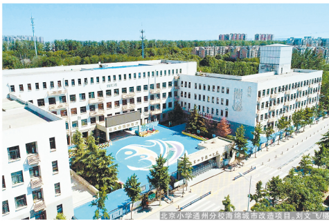
结合海绵城市的理念，项目团队在改造中，将过去不透水的硬化改造为透水地面，还配备了活动座椅和地垫、人行道和停车位重新做了铺装，改造成了透水道路和透水停车位。
