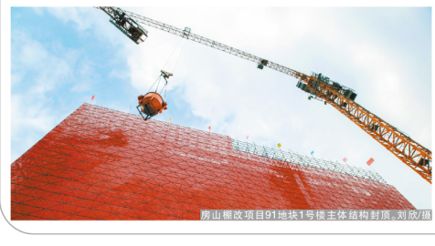
房山棚改项目91地块1号楼主体结构封顶。刘政/摄
