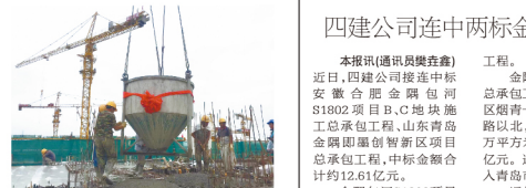
3号楼最后一层混凝土浇筑，刘长伟/摄
