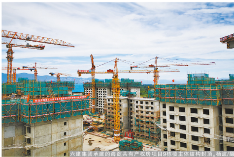
六建集团承建的海淀共有产权房项目9栋楼主体结构封顶。杨毅摄
