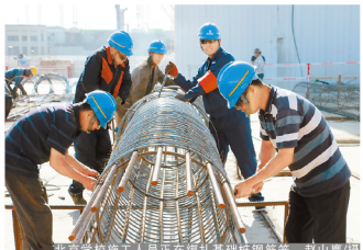
北京学校线施工人员进行绑扎基础钢筋作业。赵山鹰/摄
