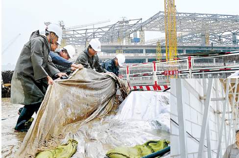
项目配备专业、兼职安全员,确保安全管理横到边、纵到底,无死角、全覆盖,经常性地开展安全生产检查。
