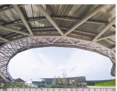
项目钢结构金属屋面穿孔铝板幕墙结构
