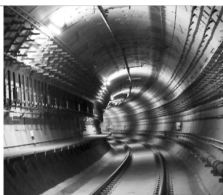
↑ 上图为北京地铁14号线阜通站至望京南站隧道。该区间由盾构法调整为暗挖法施工。
