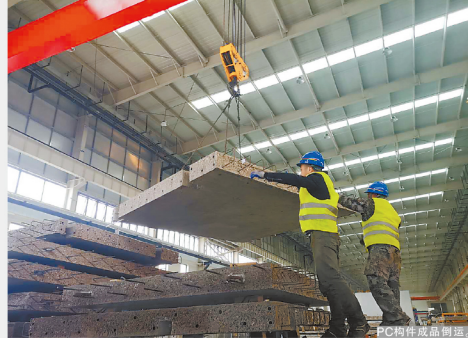
新材恒均科技公司施工现场
