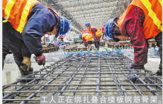
工人进行绑扎作业
