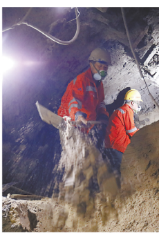
北京地铁3号线施工现场
