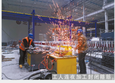
工人进行焊接施工
