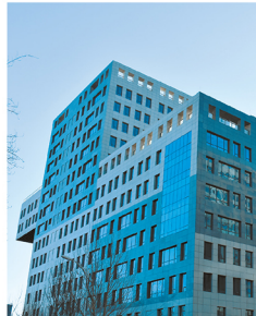
中关村电子城国际电子总部1号科研楼等6项工程顺利竣工。
