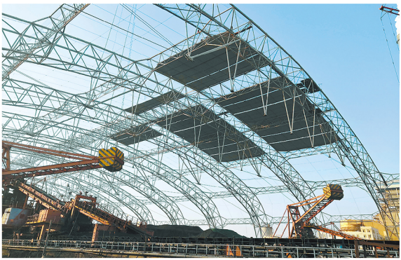
机施集团钢结构技术人员围绕专业工作,每年报送多份合理化建议。图为合理化建议——大跨度桥梁滑移施工方法在河北省唐山大唐国际电厂发电煤场应用。
