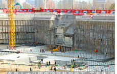
冬奥人才公租房项目施工现场,王宏伟摄
