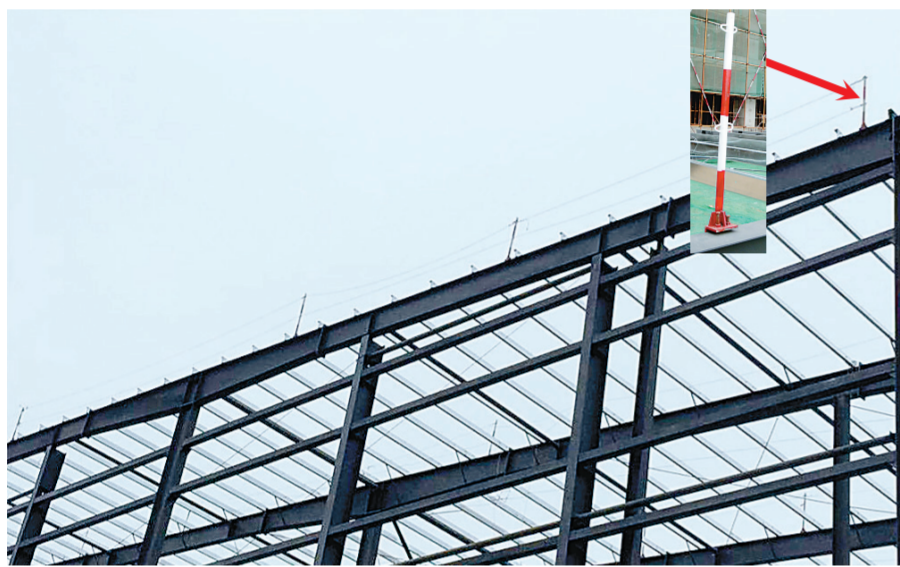
钢结构顶部作业改用立柱式双道安全绳防护,既安装方便,又确保工人钢梁上行走、作业更加安全。
