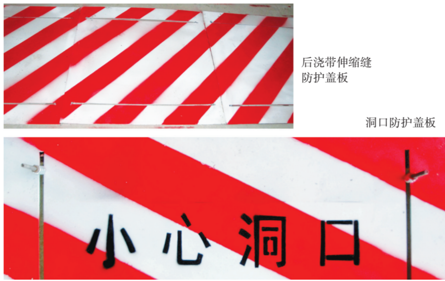
洞口、后浇带伸缩缝防护盖板采用钢板定型盖板可满足不同尺寸洞口防护需要,与原有木胶合板盖板相比具有稳定性好,不易破损、位移,便于周转再次利用的优点。
