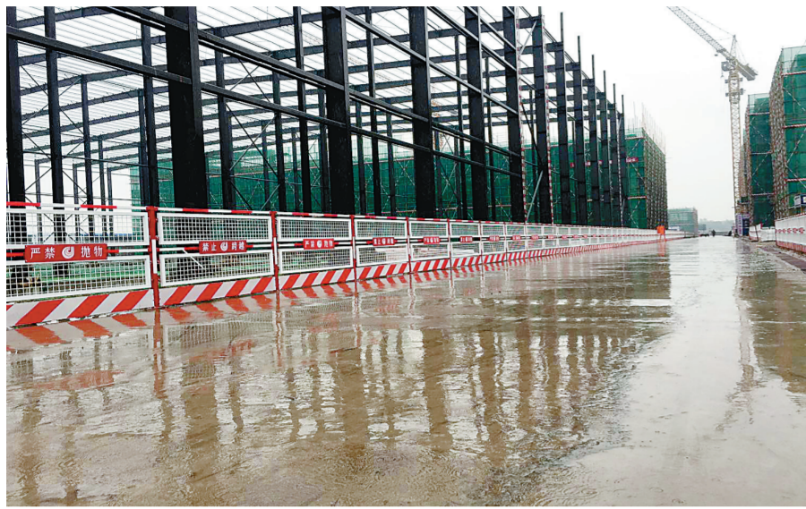
新版防护栏杆与之前的防护栏杆相比,各杆件、挡脚板、网片均可组装拆卸,便于受损更换;网眼由原来40×40mm改为20×20mm,更有效的防止物料从高处坠落。
